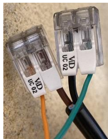
6. Raccordez les fils : orange avec marron, vert avec noir
