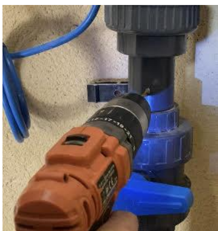
1. Percer un avant-trou dans le tube avec une mèche de \varnothing 3 ou 4 mm.
