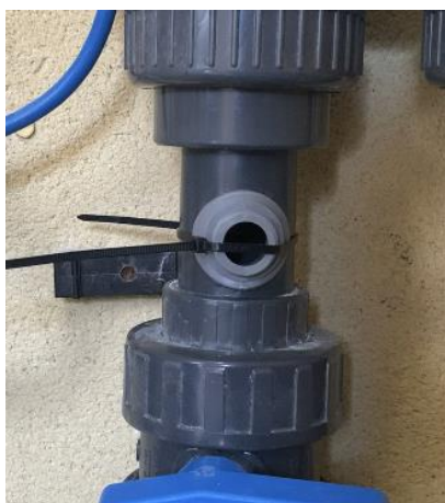
4. Décapez, collez puis maintenez quelques minutes avec un serre-câble
