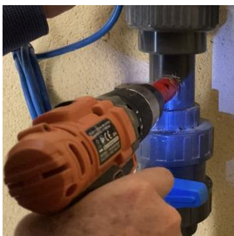
2. Percer avec une scie cloche de \varnothing 25 mm.
